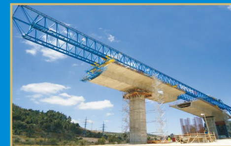
LG型节段拼装架桥机在以色列架梁施工 LG construction in Israel
